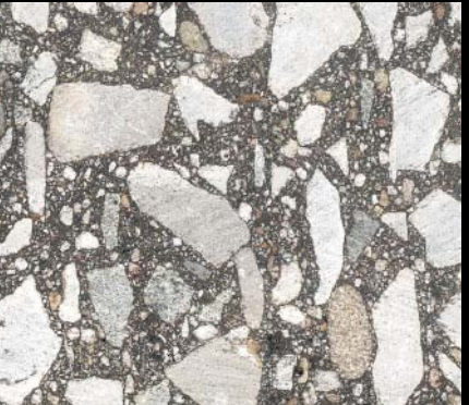
Abb. 1: Querschnitt durch einen Asphalt-Bohrkern
